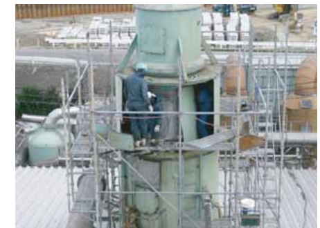
設置工事風景
